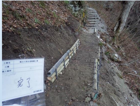
尾白川溪谷道工事状況
