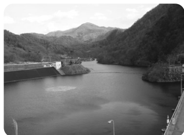
清里湖にも巨大橋？
