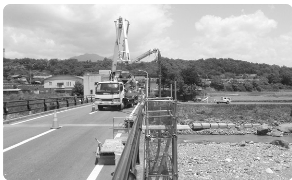
三村橋補強工事
