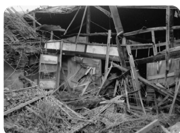
放置された空き家
