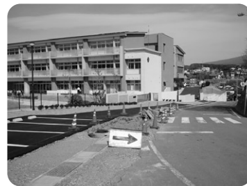
進む通学路の改修
