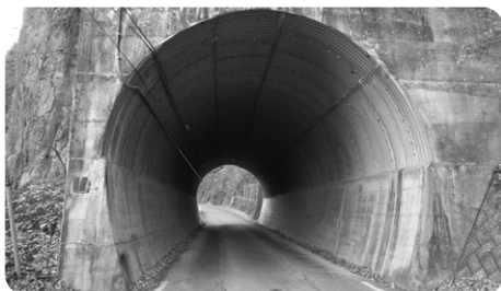
緊急点検されたトンネル
