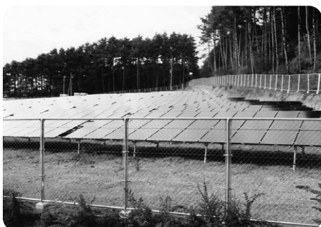
災害が危惧される急傾斜地の太陽光パネル
