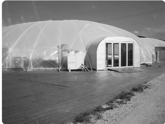
全40棟の建設が進む農業ドーム(白州町)
