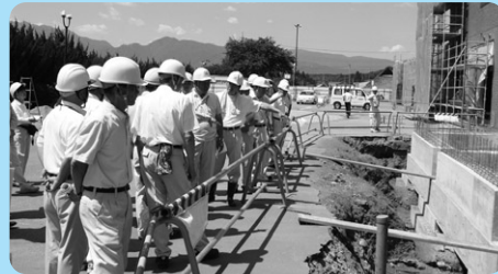
大泉総合会館改修
