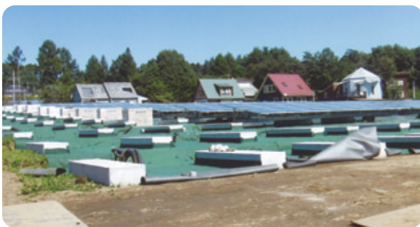
建設中の太陽光パネル
