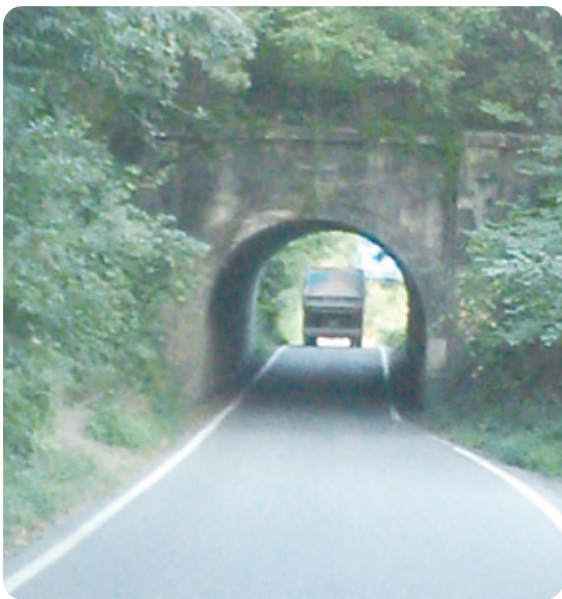
狭くて暗い武川日野春隧道
