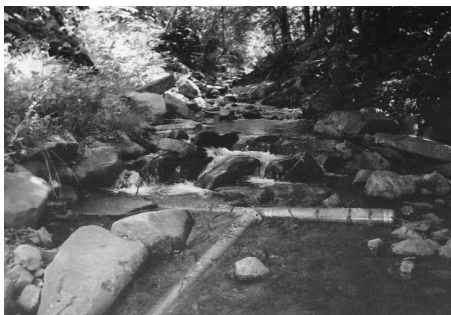
早期改善が望まれる黒森地区の水道水源
