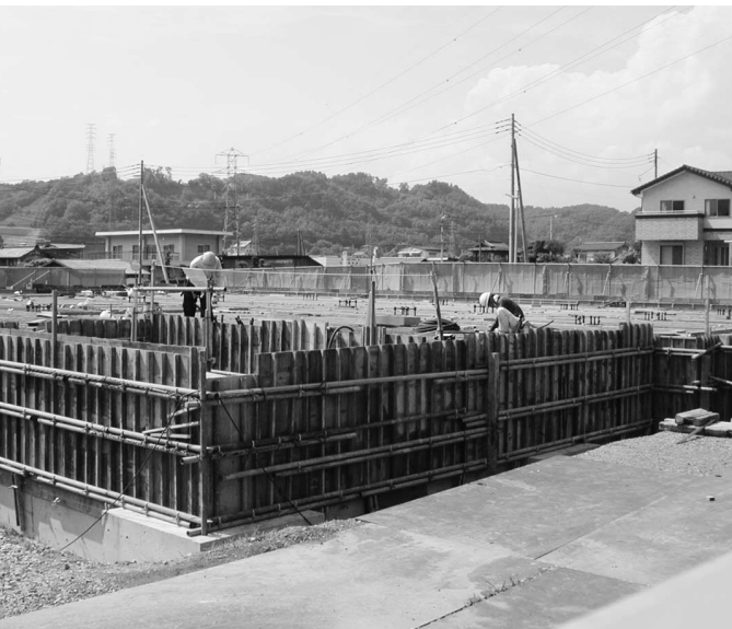
基礎工事が進む給食センター
