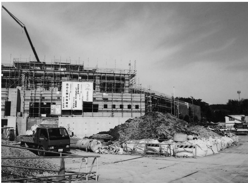
完成が待たれる小淵沢中学校
