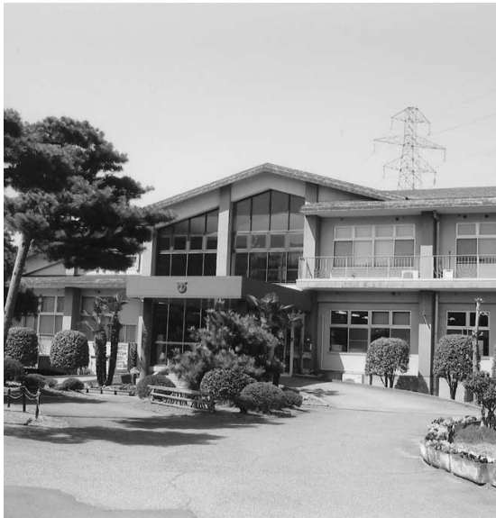
昭和39年に建てられた武川総合支所
