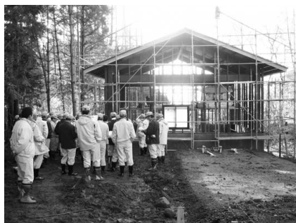
工事が進む発電所
