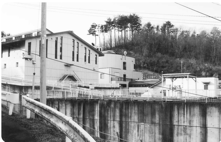
水道企業団の塩川浄水場
