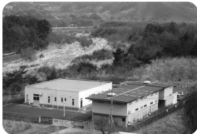
武川町第1水源配水池
