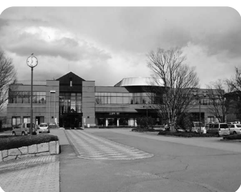
宿直がなくなった総合支所
