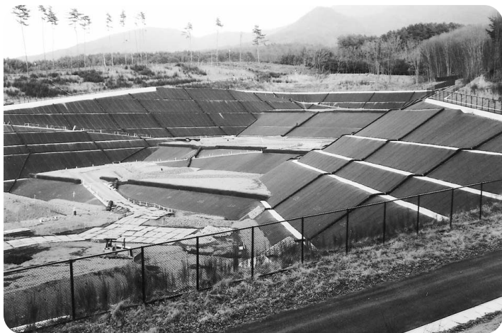
安全管理委員会が開かれる最終処分場
