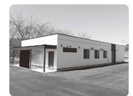
長坂スポーツ公園クラブハウス
