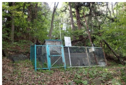
写真:三ツ子沢配水池(1983年:40年経過)
