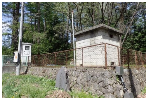
写真:東井出配水池(1961年:62年経過)
