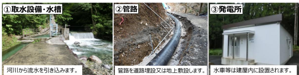
図 3-4-1 水力発電所の概要（出典：NEDO「マイクロ水力発電導入ガイドブック」編集）
