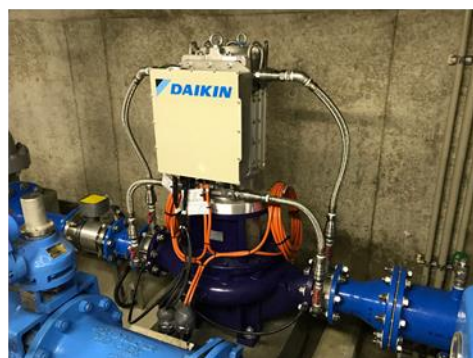
図 3-4-4 水道施設内（須玉第二減圧槽）の「マイクロ水力発電（最大出力19.9kW）」
