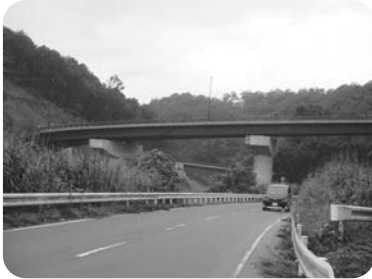
整備が急がれる道路
