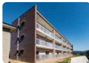
▲ 定住促進住宅(外観)
